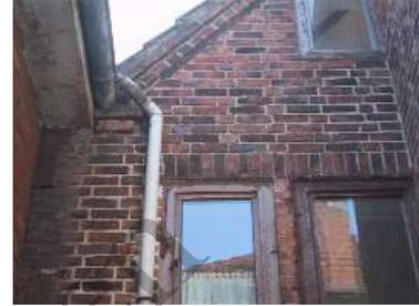
Das Haus weist von außen einen, dem Baujahr entsprechenden Pflegezustand auf. Das Dach, das nach Aussage des Maklers noch ursprünglich ist, hat Instandsetzungsbedarf. Die Klinker und Verfugung der Fassade sind teilweise ebenfalls instandsetzungsbedürftig.
